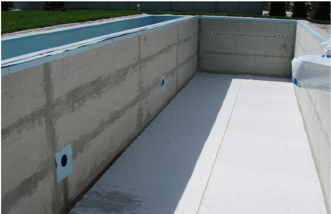
Abbildung 2: Verlegung relax Biopool.
