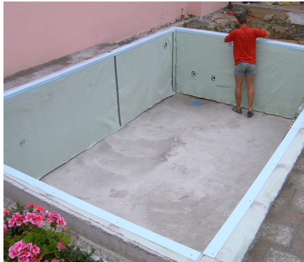
Abbildung 4: Verlegung relax Schwimmbadbahn.
