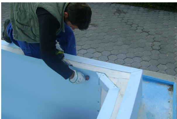
Abbildung 9: Aufschweißung der Schwimmbadbahn auf den Verbundblechwinkel
