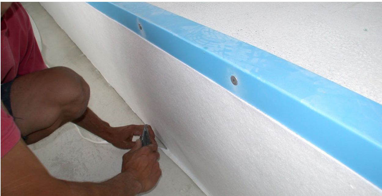
Abbildung 6: Waagrecht befestigter Winkel aus beschichteten Agru Relax Verbundblech und Aufbringung eines Schutzvlieses im vertikalen Bereich
