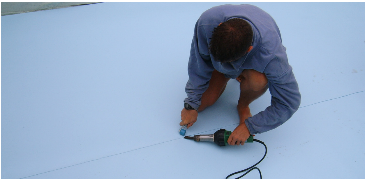
Abbildung 14: Verschweißung mit Heißluftföhn.
