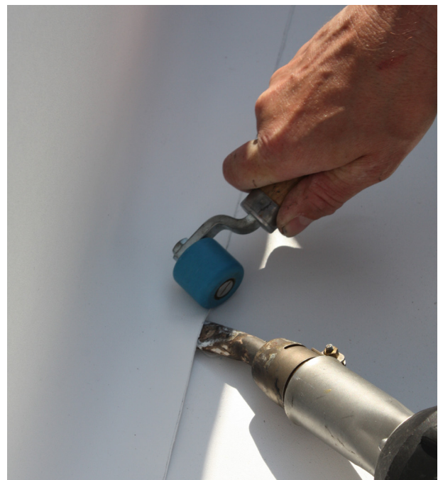
Verschweißung der Schwimmbadbahn auf die Bahn der Wandfläche im Hohlkehlenbereich
