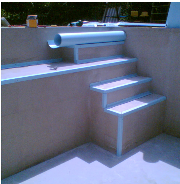
Abbildung 7: Installation Verbundblech im Bereich der Treppen
