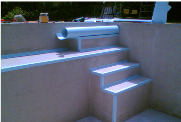
Abbildung 10: Montierte Verbundblechwinkel an Innen- und Außenecken
