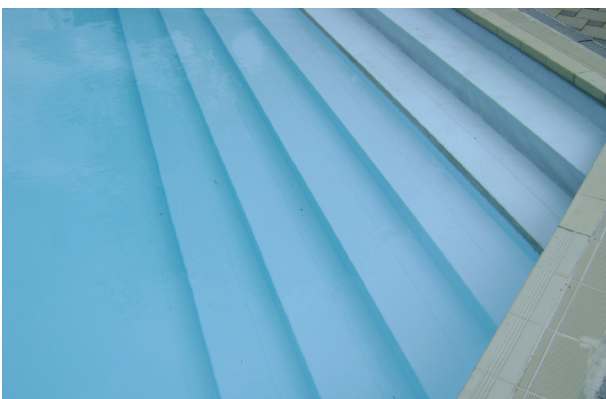
Abbildung 12: Fertig ausgeführte Treppenauskleidung
