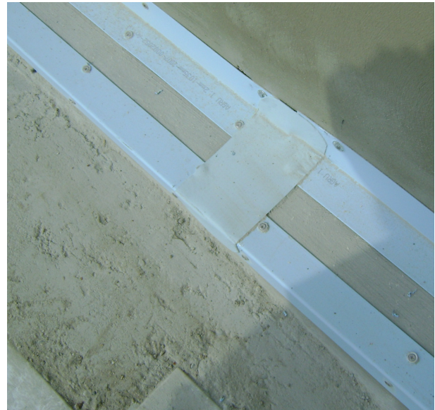
Abbildung 8: Detail Verbundbleche bei Treppen
