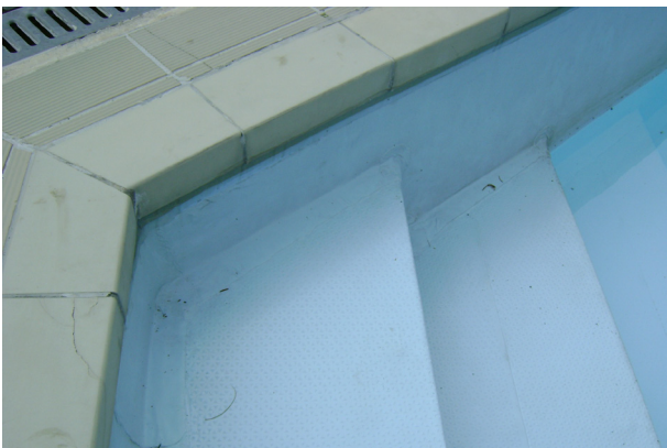
Abbildung 11: Auftrittflächen ausgeführt mit rutschhemmender Agru Relax Schwimmbadbahn
